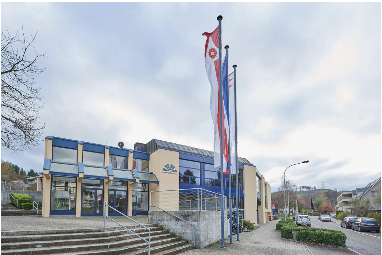
Abbildung 1 - Gemeindezentrum Brüelmatt, Birmensdorf ZH
